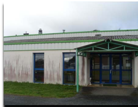
Entrée de l'atelier Crédit photo : G. WAGNER
